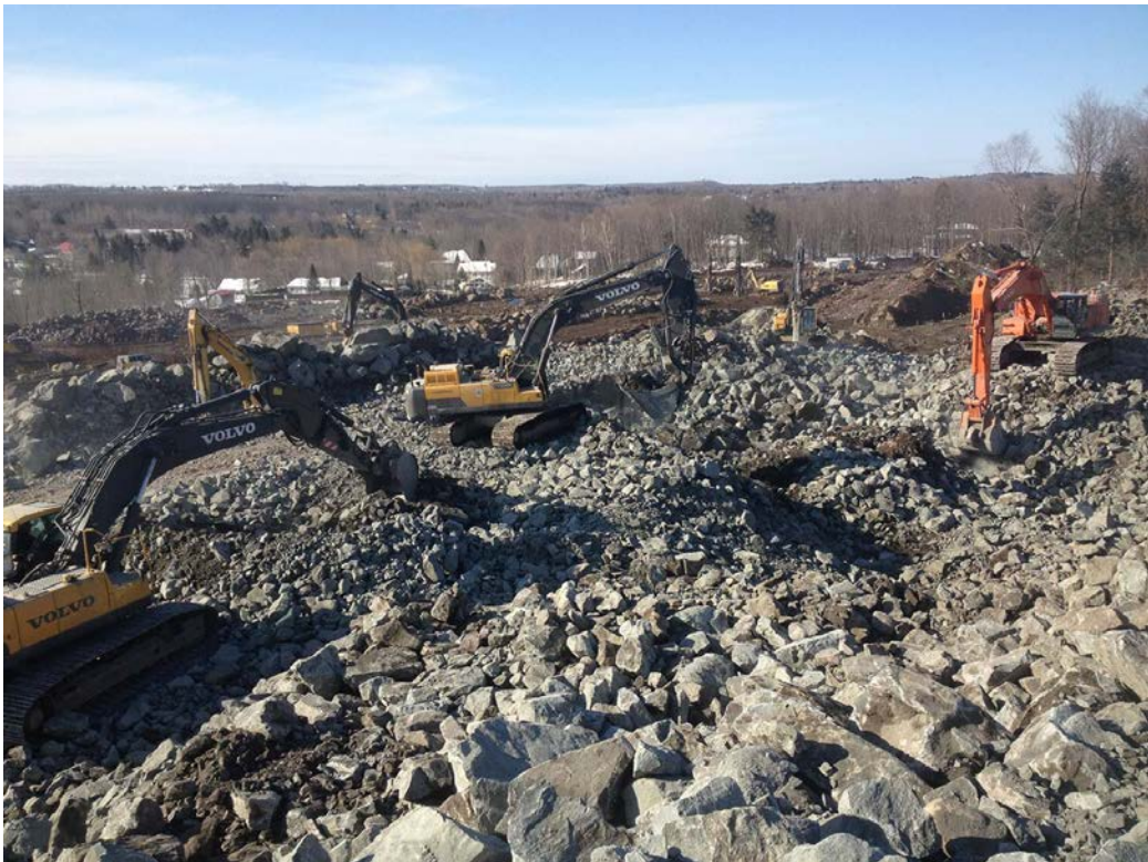
Photo 4 : Roc-Pointe, secteur St-Nicolas aplanissement et transformation du cran rocheux après la coupe à blanc, Les excavations Lafontaine inc.
