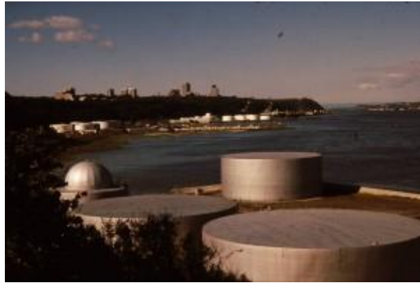
Côte de Sillery avant démantèlement des réservoirs.
